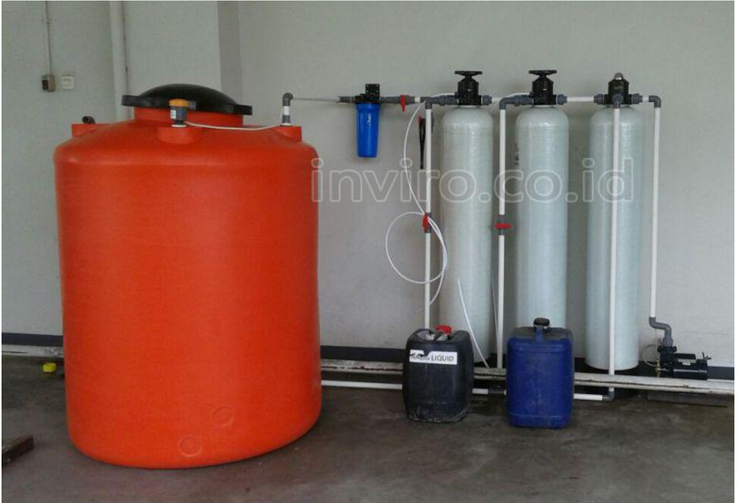
Gambar: Contoh rangkaian unit WTP Demineralisasi by INVIRO yang sudah selesai terpasang dilokasi customer
