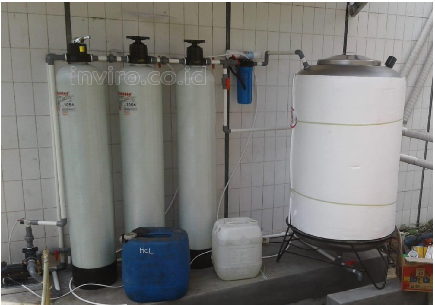
Gambar: Contoh rangkaian unit WTP Demineralisasi by INVIRO yang sudah selesai terpasang dilokasi customer
