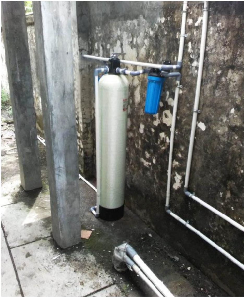
Gambar : Contoh Unit Paket Filter WTP ( Water Treatment Plant ) Penjernih Air Untuk Ternak Ayam (Agar Air Menjadi Sehat & Higienis) yang sudah terpasang dilokasi.
